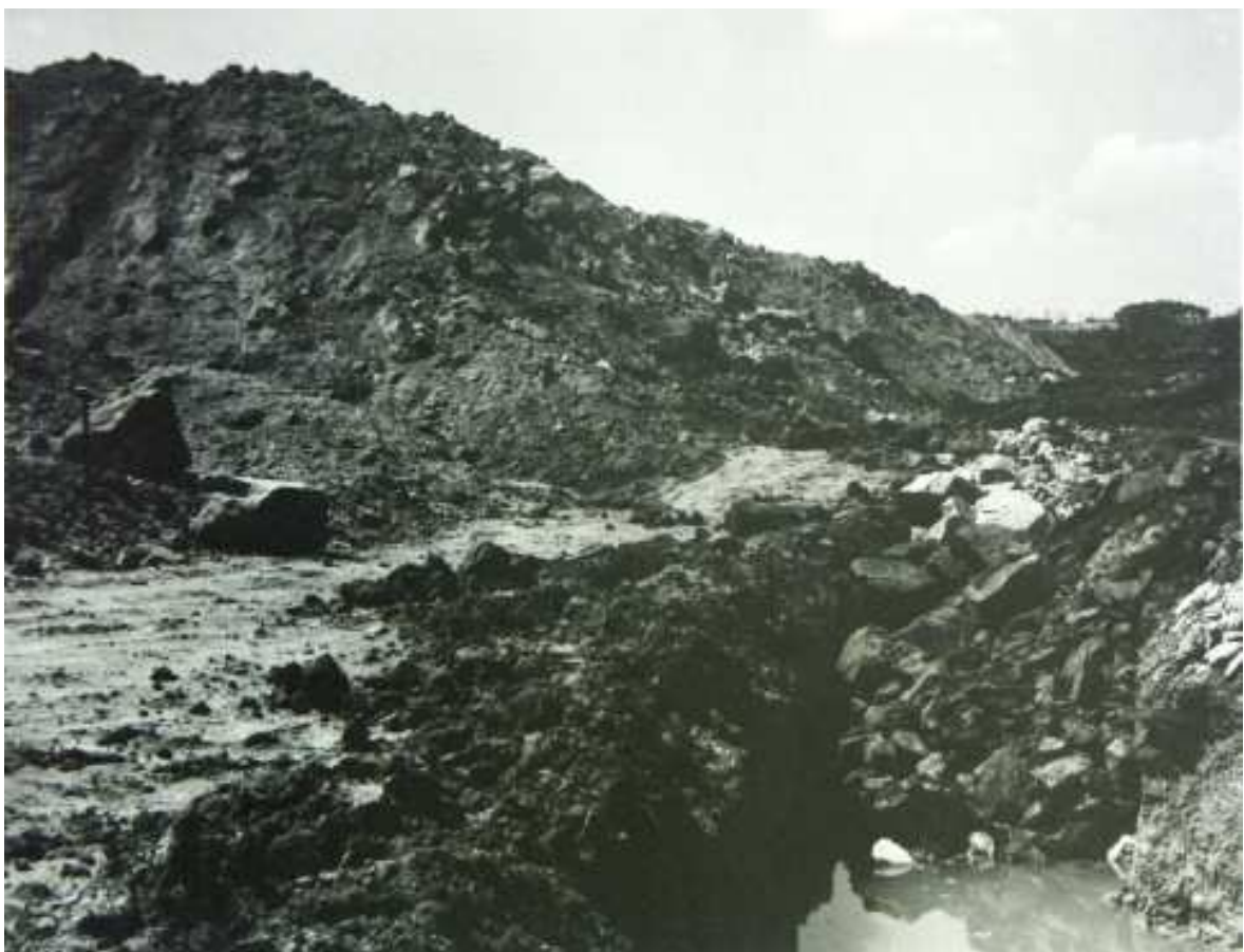
Navržený val z lomového kamene, na jeho patě budované odvodnění. (Foto - archiv SU)
