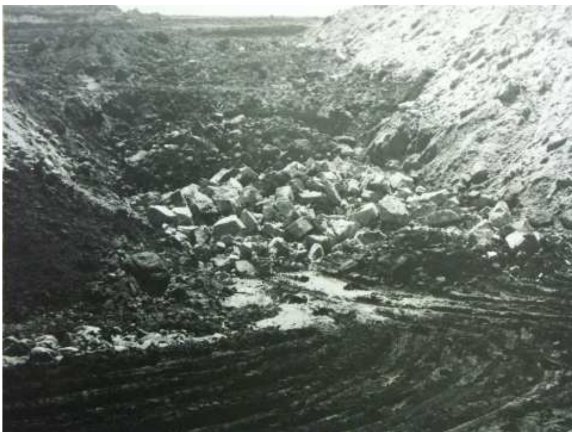
V předstihu budované "kastlíky" z lomového kamene a propojování drenážního systému. V levém horním rohu je viditelná skluzná hrana po níž došlo k poklesu tělesa výsyvky. (Foto - archiv SU)
